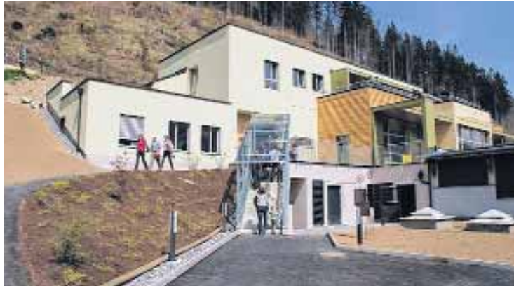
Übelbach: Die besondere Hanglage, die dem Gebäude allerdings ein besonders schönes Flair verleiht, verteuerte das Projekt. Foto: Gemeinde Übelbach
