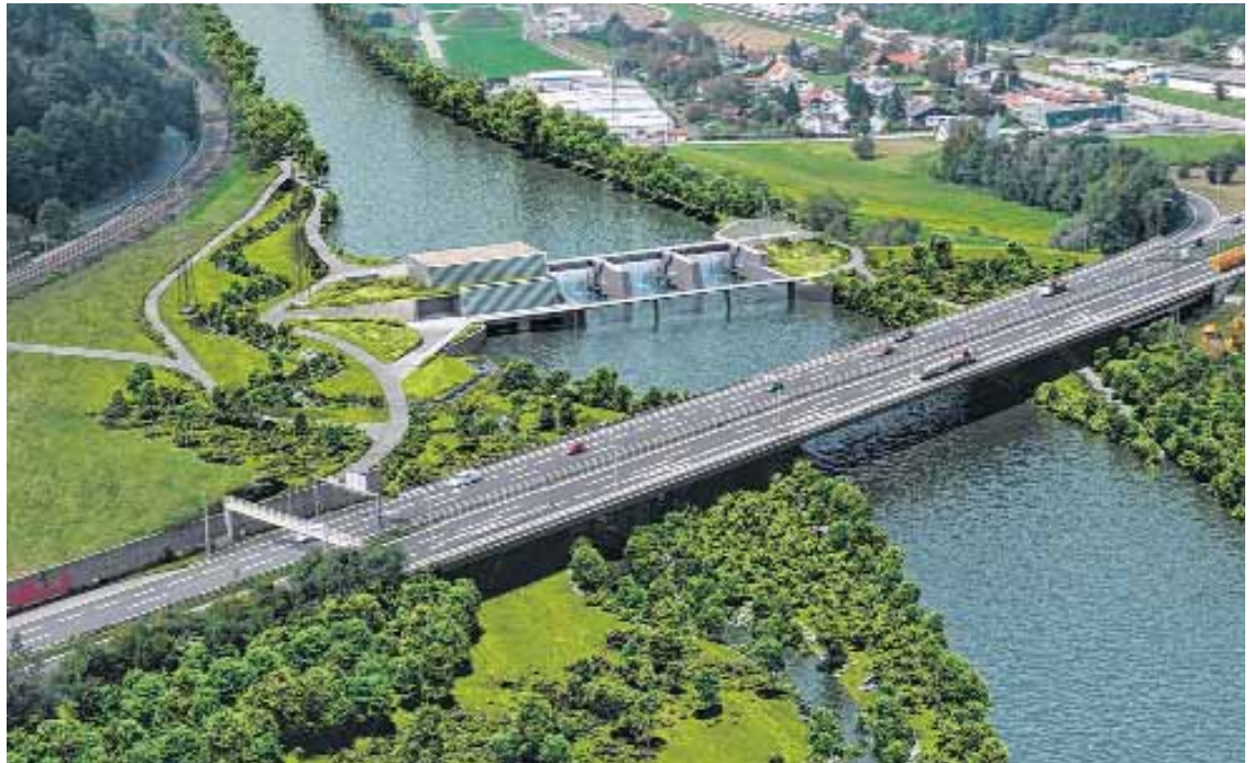
Grünes Licht für die neue Verbund-Anlage in Gratkorn?
