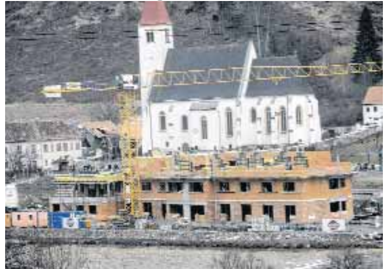
In Übelbach bleibt derzeit kein Stein auf dem anderen: Hier soll bis spätestens November 2011 das erste Pflegeheim der Region entstehen. Foto: KK
