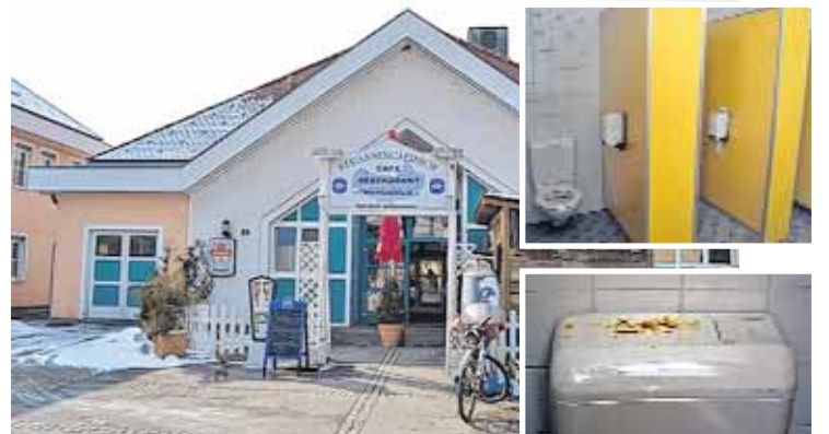
Strassenglerhof: Von den abendlichen Veranstaltungen gezeichnet ist das Klo im Strassenglerhof, tagsüber aber durchaus benutzbar.
