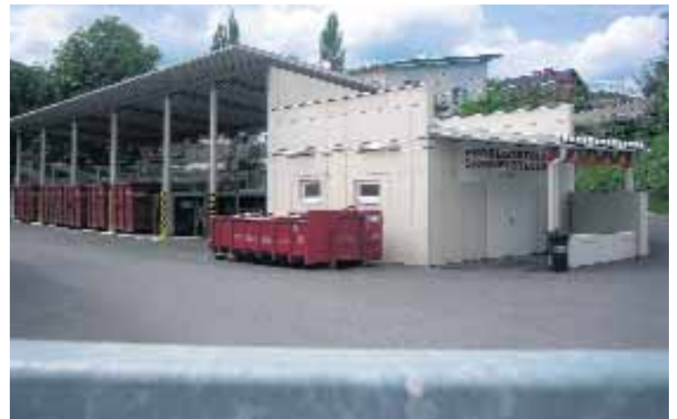
Mit dem Altstoffsammelzentrum bietet Judendorf seinen Bürgern entsprechende Abgabestellen für Sperr- und Sondermüll und setzt damit ein klares Zeichen für die Umwelt. Foto: KK
