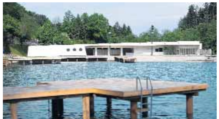
Das generalsanierte Nah-Erholungsparadies Bad Weihermühle spielt nach den umfangreichen Umbauarbeiten alle Raffinessen und wird am 5. Juni feierlich eröffnet.
