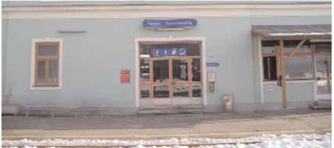
Streitpunkt Bahnhof: Die Bewohner der Bodenfeld-Siedlung müssen sich zukünftig auf eine erhöhte Lärmbelastung einstellen. Foto: KK
